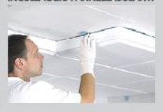
INCOLLAGGIO PANNELLI ISOLANTI
